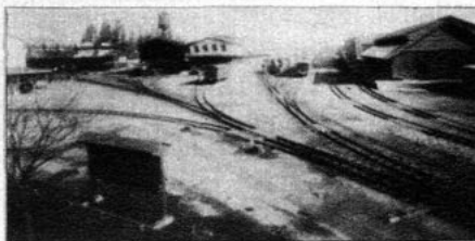
Aspecto general del patio de Rancagua.
