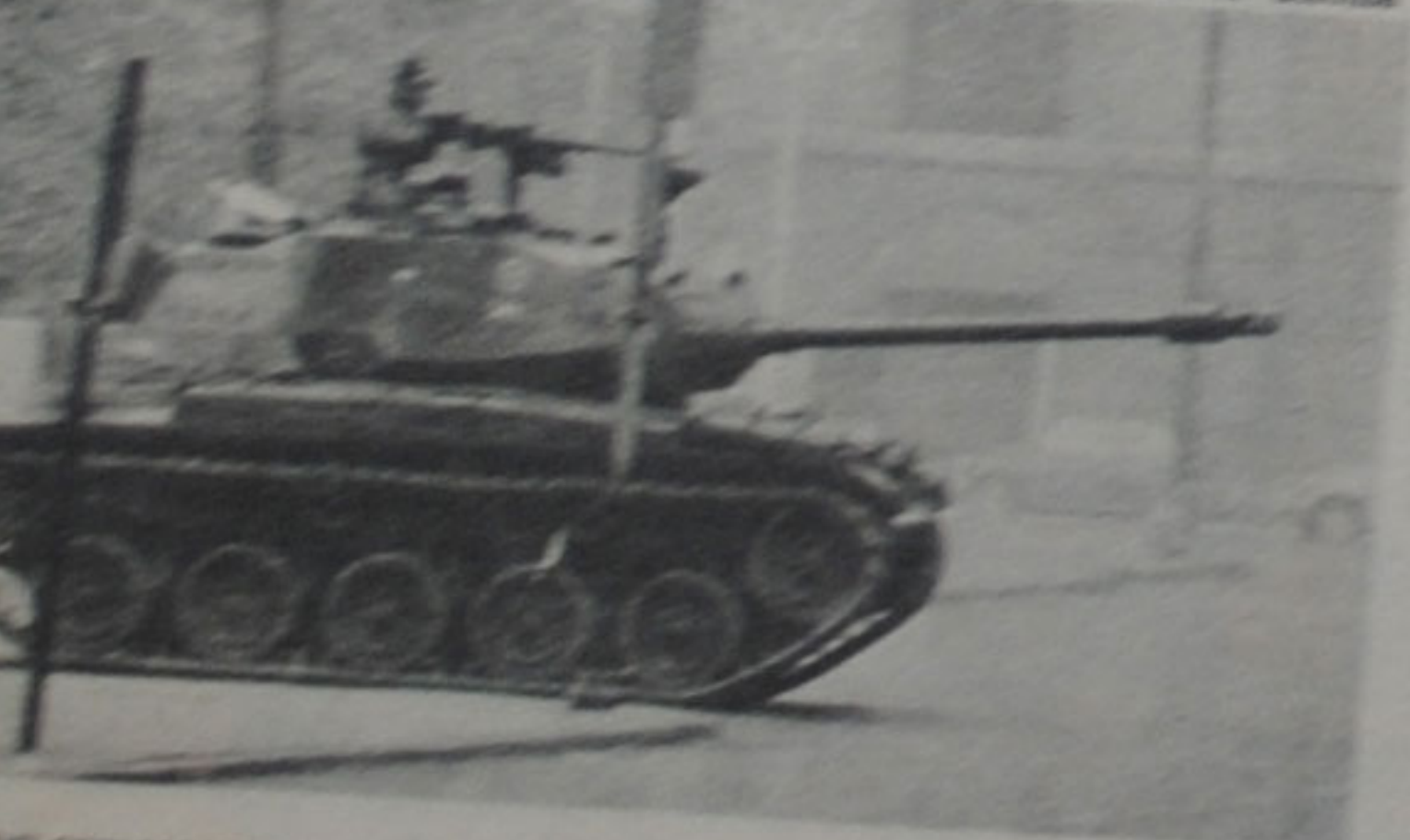
EN MOMENTO EN QUE SE DESARROLLABA este tanque mantuvo la posición durante tres horas. Desde él se hicieron la mayoría de los disparos a metralla que destruyeron parte del frente de los edificios aledaños en la calle de Aguilera.
