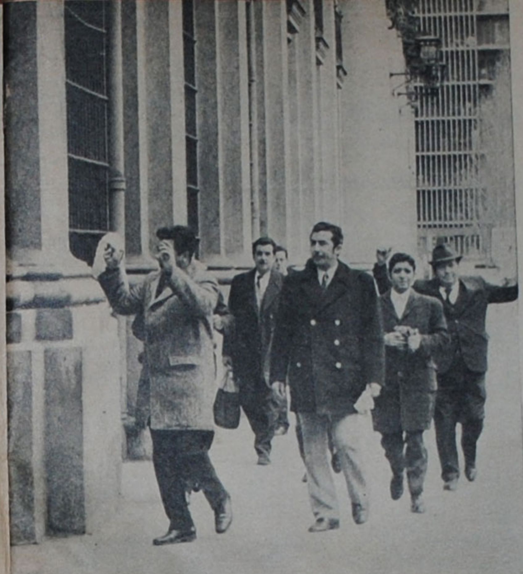
FUNCIONARIOS de La Moneda abandonan el Palacio minutos antes del bombardeo. ABAJO: Un desolador aspecto de la destrucción interior que sufrió el Palacio Presidencial diseñado por Toesca, célebre arquitecto italiano.
