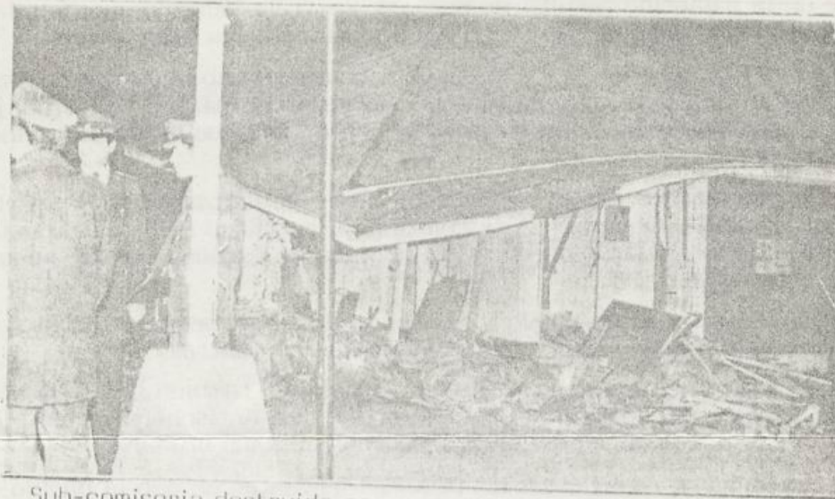
Sub-comisería destruida por grupos operativos del FPMR.
