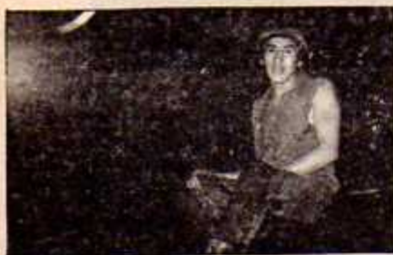
En el "frente de laboreo", es decir, de la perforación del túnel, con casco, botas de agua y rodilleras por todo equipamiento.
