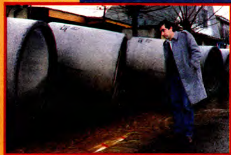
En el distrito, fiscalizando las obras de entubamiento.
